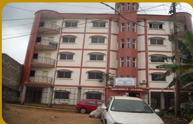
Immeuble Siège de l'OCFSA à Yaoundé au Cameroun (2e au 4 e étage).
